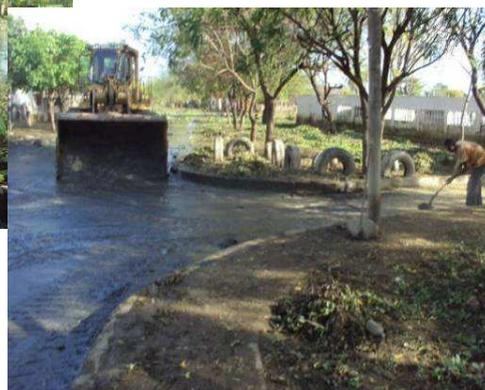
**FOTO 2 y 3.** Limpieza y retiro de vegetación , sedimentación y residuos resultantes de la inundación.
