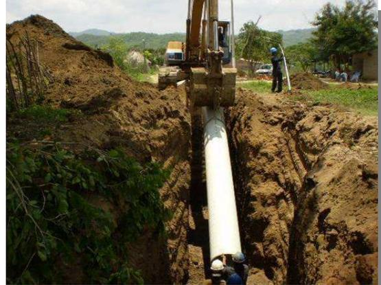
**Repelón:** Sistema de tratamiento de aguas residuales, estación de bombeo y línea de impulsión.
