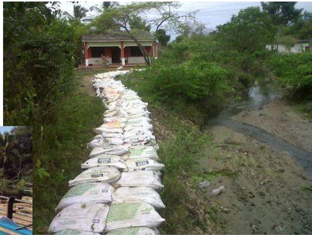
**FOTO 1 y 2.** Suministro e instalación de sacos para atrincheramientos
