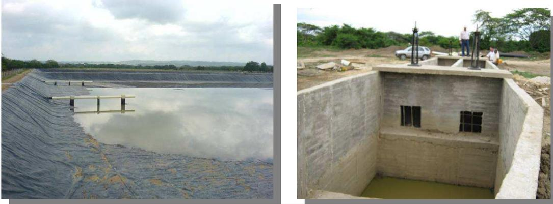
Laguna de Estabilización y Desarenador de entrada a sistema de tratamiento de aguas residuales Municipio de Manatí
